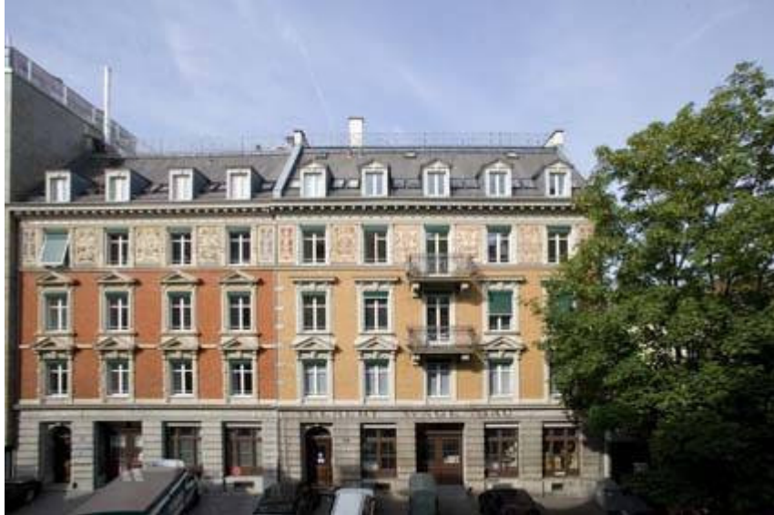
Weitgehend erhaltene Jugendstilfassade, Abschwächung der Monotonie des Zwillingshauses durch verschiedene Farbtönung. Mühlebachstr. 14 (1896)
