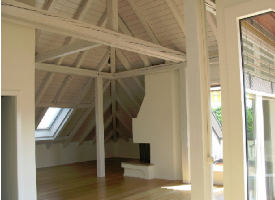
„Offenes Dach“, Titlisstr. 37, 8032 Zürich
