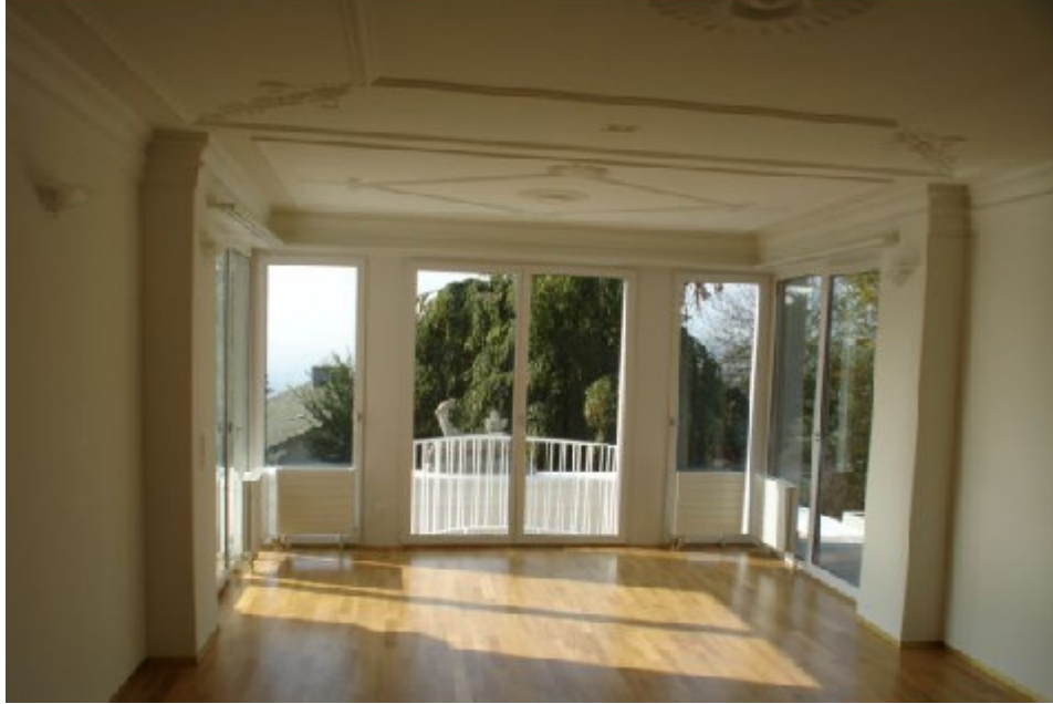
Deckenstukkatur und Ziersäulen, Germaniastr. 39, 8006 Zürich
