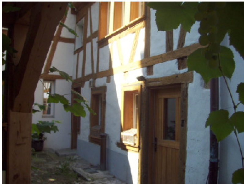
Riegelhaus aus spätgotischer Zeit. Hottinger Bauernhaus, Klosbachstr. 84, 8032 Zürich (erbaut 1528)
