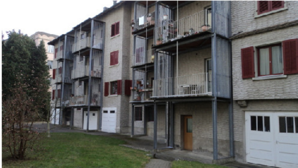
Nachträglich angebrachte Balkone, Eugen Huber-Str. 24, 8048 Zürich
