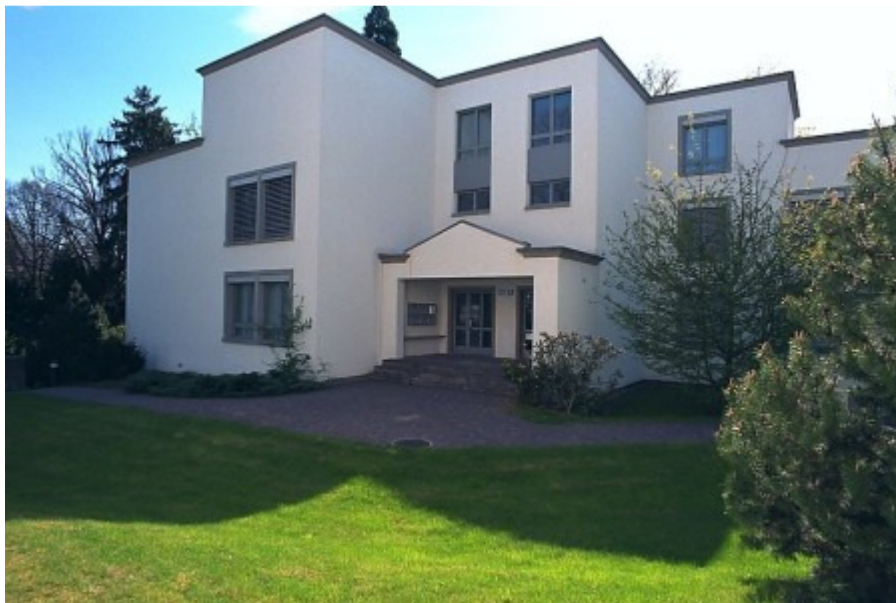
Bauhausstil mit klassizistisch inspiriertem Eingangsportal, Parkring 55, 8002 Zürich (erbaut 1992)
