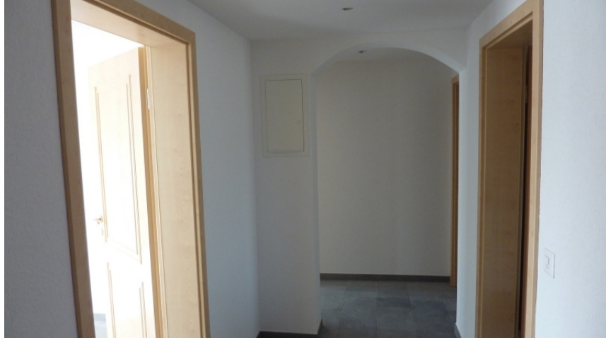
Rundbogen Gewölbe in der Wohnung, Cramerstr. 16, 8004 Zürich (1893)
