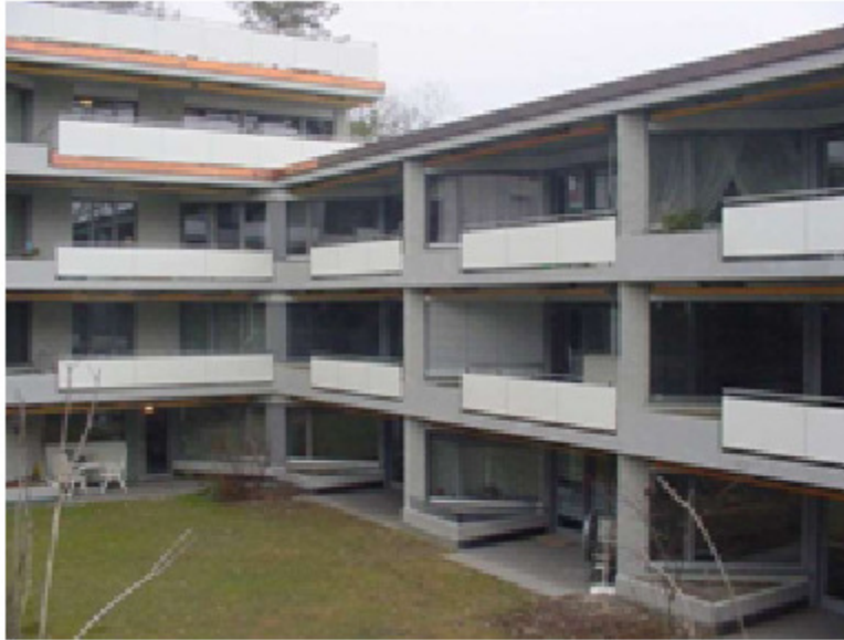
Seitwärts offene Loggiabalkone, Etzelstr. 28, 8038 Zürich (erbaut 1969)
