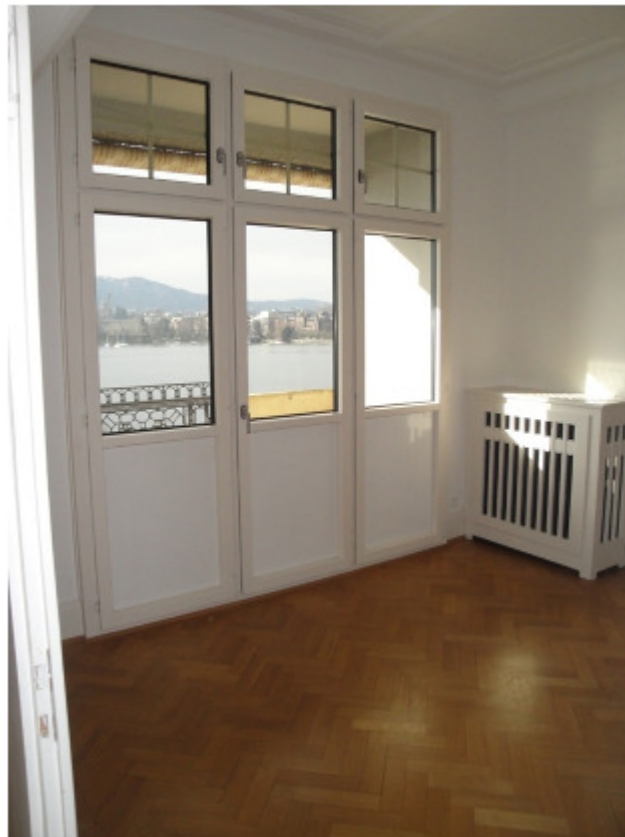
Eingeschlossener Radiator, Utoquai 39, 8008 Zürich (1910)
