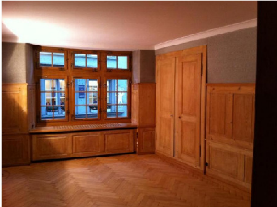
Holzverkleidung, Storchengasse 17, 8001 Zürich
