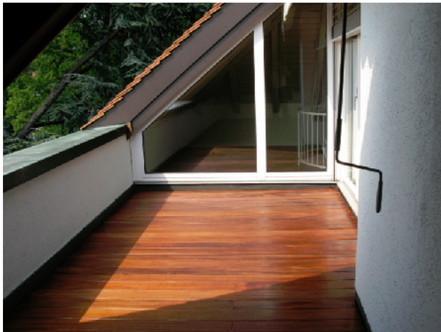
Nach vorn offener und seitlich transparenter Dachbalkon, Titlisstr. 37, 8032 Zürich
