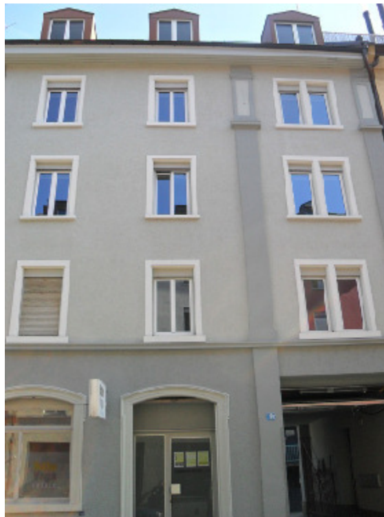
Glastüre der 50er/60er Jahre, Zwinglistr. 8, 8004 Zürich
