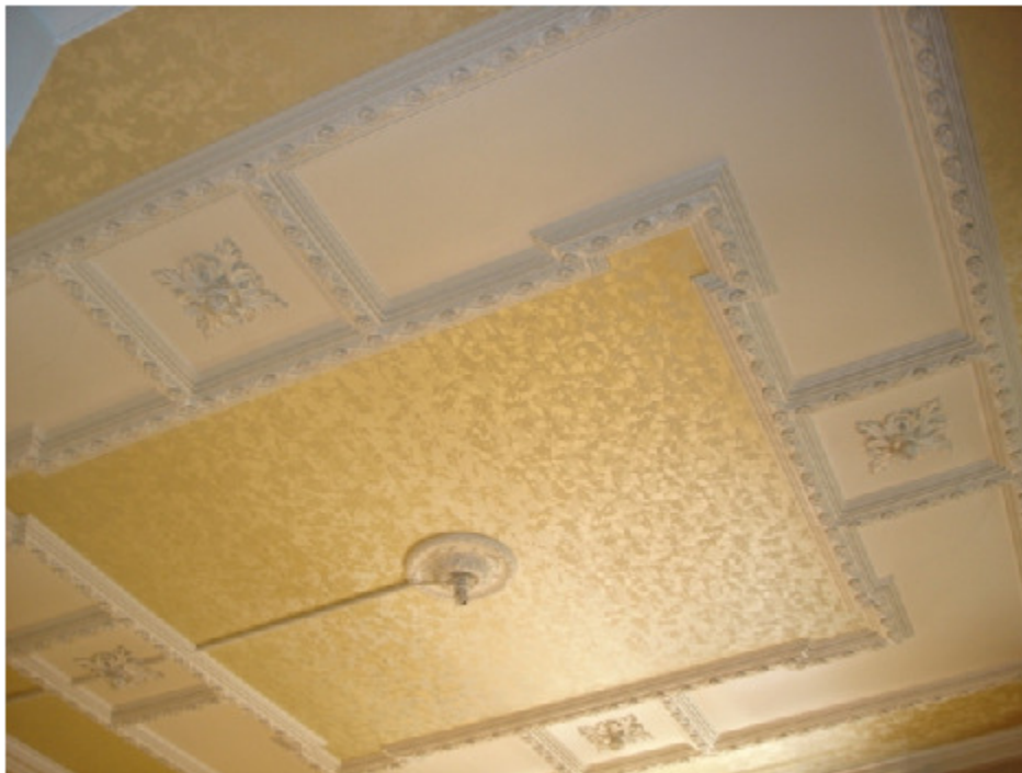
Stukkatur und Bemalung der Decke, 8037 Zürich (1896)
