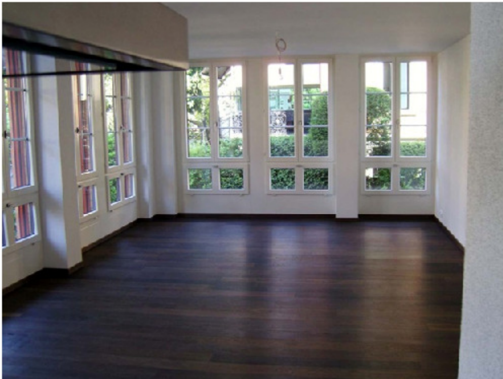
8-fach unterteilte Fenster. Weinbergstr. 113, 8006 Zürich (erbaut 1993)
