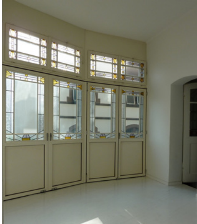
Schiebewand mit farbigen Glaseinlagen, Ottikerstr. 24, 8006 Zürich (1906)
