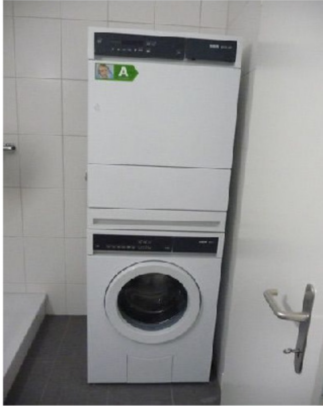
Waschturm, Dubsstr. 36, 8003 Zürich
