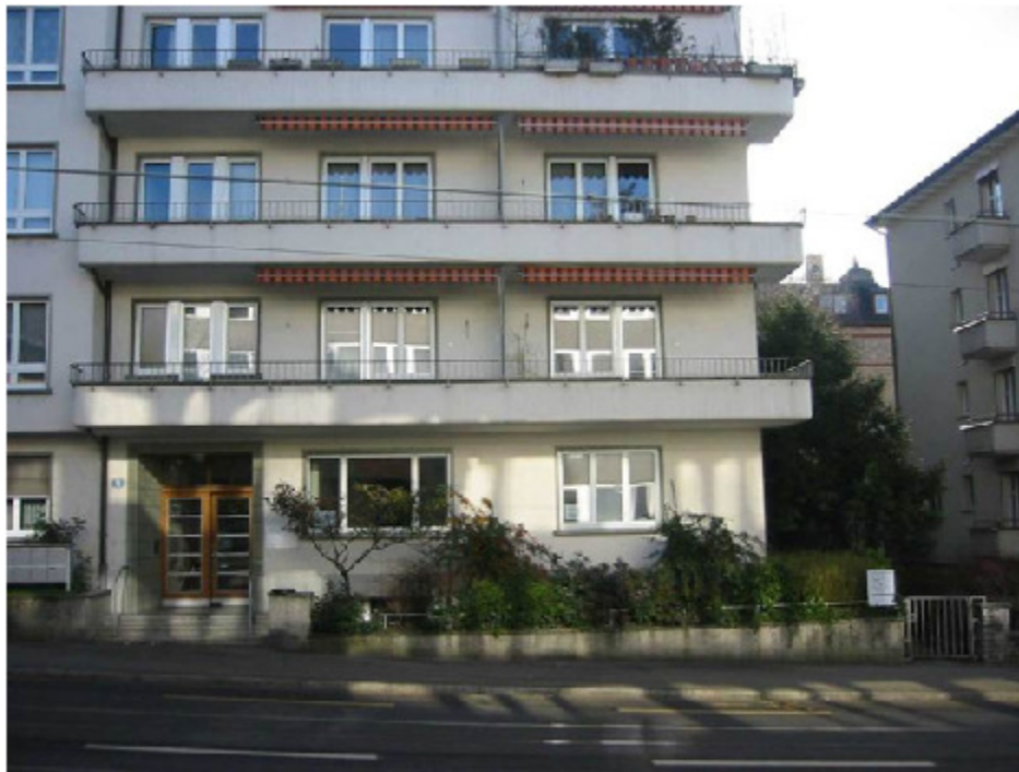
Durchgehende Balkone mit Abtrennungen, Klosbachstr. 72, 8032 Zürich (ca. 1940)
