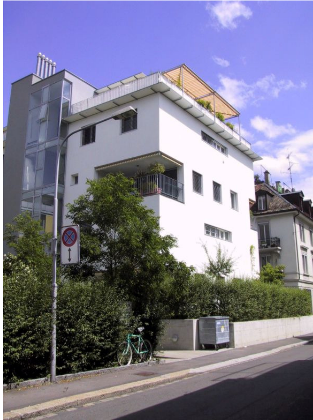
Schießschartenartige Fenster, Zimmergasse 9, 8008 Zürich (erbaut 2000)
