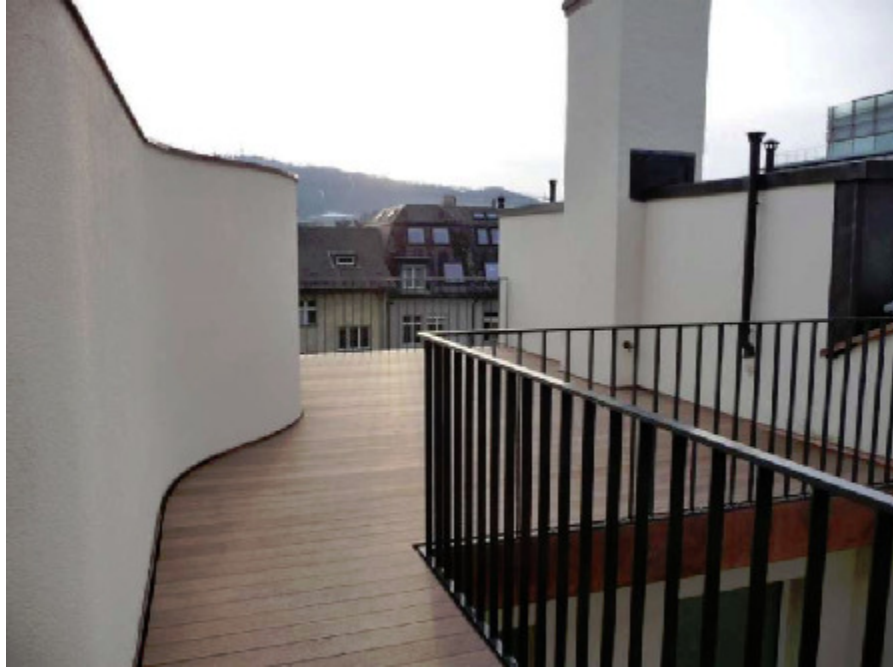
Wellenlinige Oberfläche einer Terrassenwand, Tödistr. 5, 8002 Zürich
