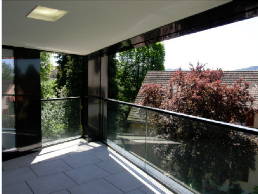
Halboffener Loggia-Balkon, Zollikerstr. 108, 8008 Zürich
