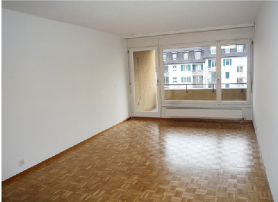
Würfelparkett, Kanzleistr. 214, 8004 Zürich (1982)
